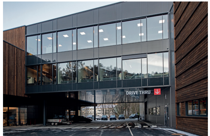
Gangbru i to plan rommer kontorer og møterom.
